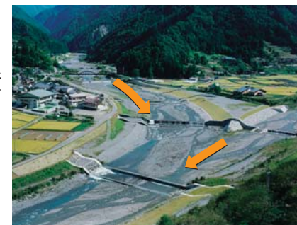
大河原床固工群（大鹿村）
