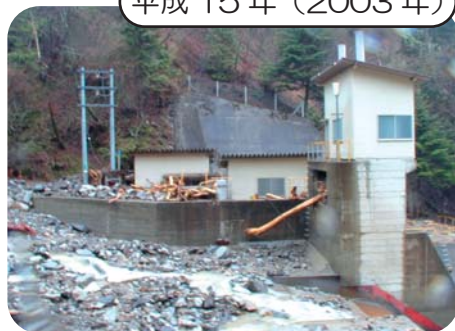
太田切川で発生した土石流により土砂で埋まった発電所施設
