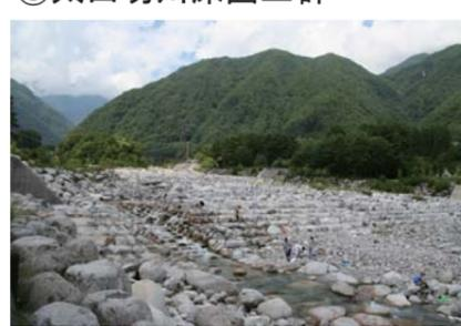
川底が削られて下流に堆積すると洪水の原因になります。床固工は、これらを防ぐためにつくられた施設です。魚が遡上できるように、魚道も付けられています。
